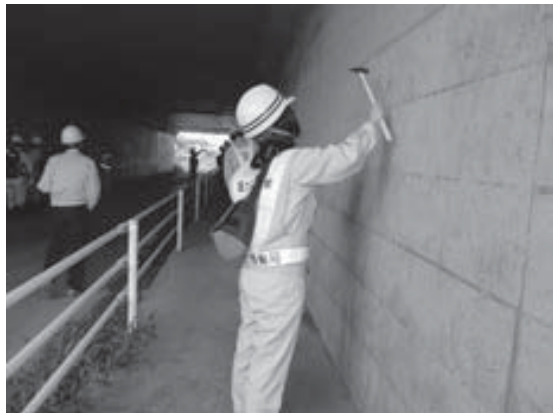
構造物点検の様子
