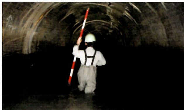
導水路内点検の様子
