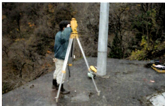
トータルステーションを用いた測量
